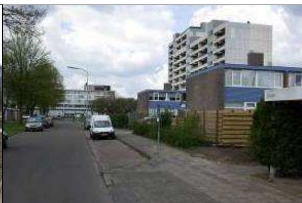
Zijtuinen in particulier gebruik aan de Holtlaan
