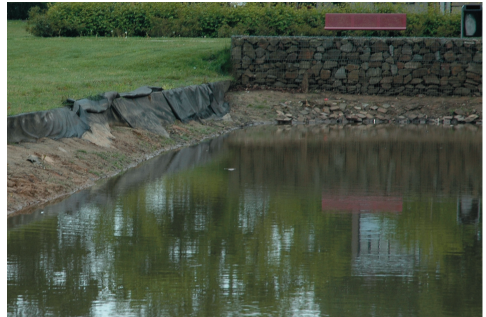
Detail vijver in wijkparkje; halfvol en achterstallig onderhoud
