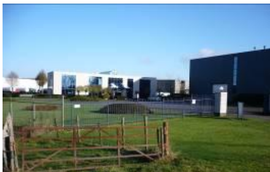
Kanaalrand- kantoor (entree) op achtererf
