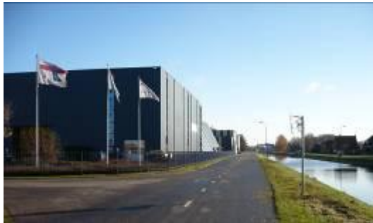
Kanaalrand- Bedrijfshal in voorgevelrooilijn
